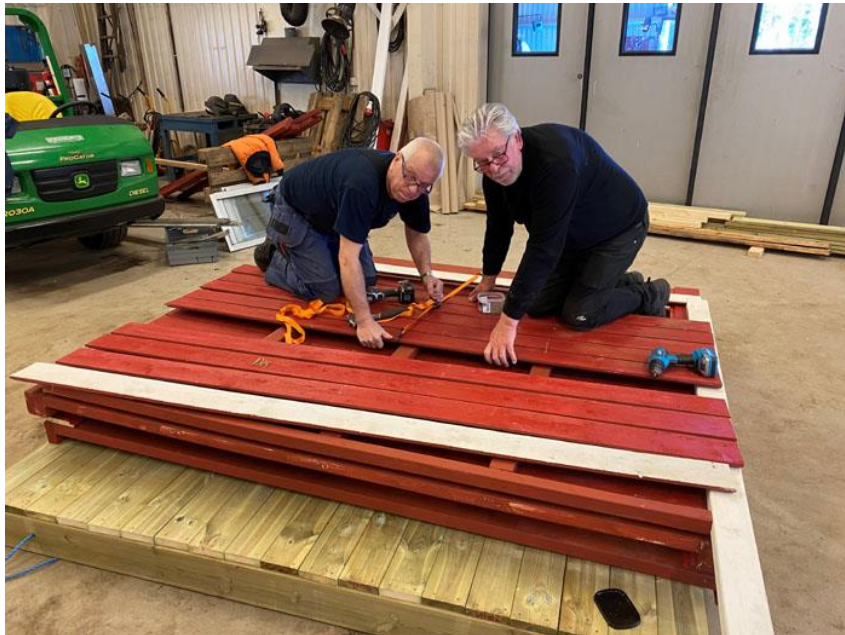
Ove och Christer skruvade panelen på blivande väggarna 28/3.
