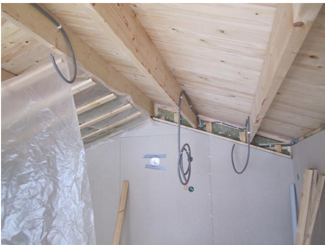
Taket i tredje huset är nästan klart
