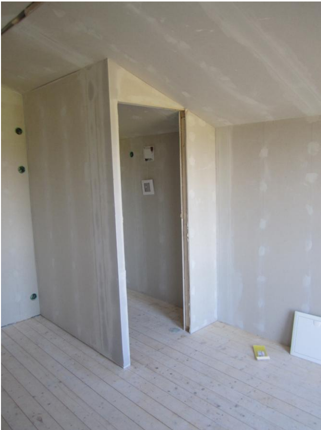
Allt är gipsat och klart i alla stugorna. Nu skall det sättas väv och sedan målas.
