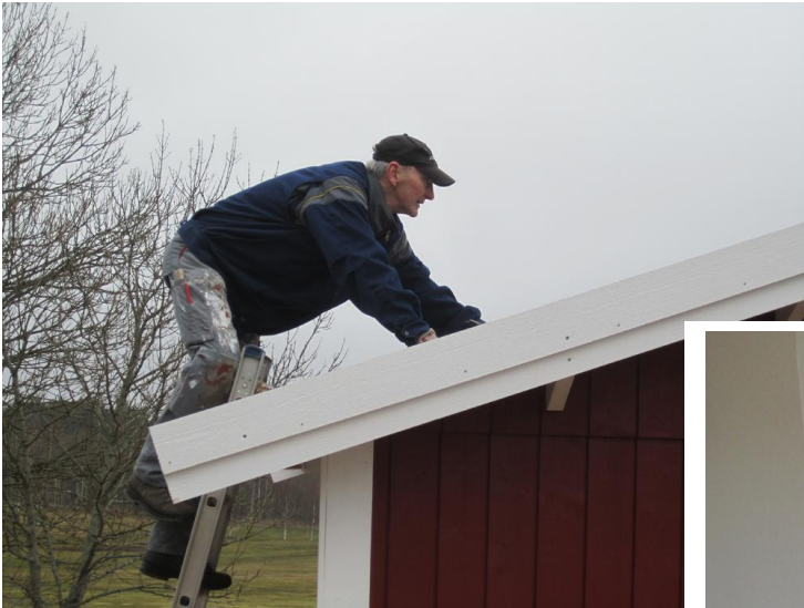
Kenneth spikar läkt så plåten kan läggas.
